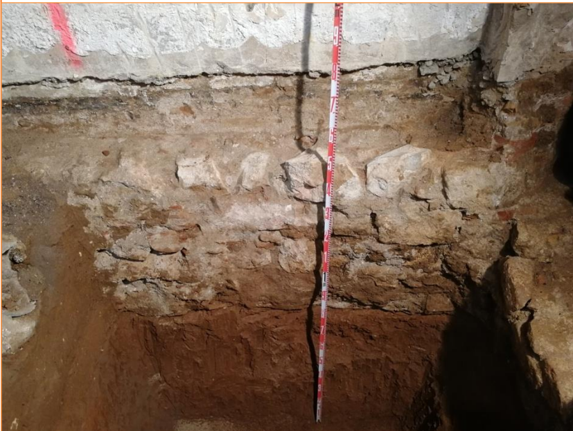
Foto 6. Vista final de la cala 4.
