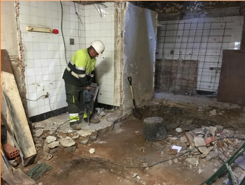
Foto 17. Vista del desmuntatge del paviment UE 1.
