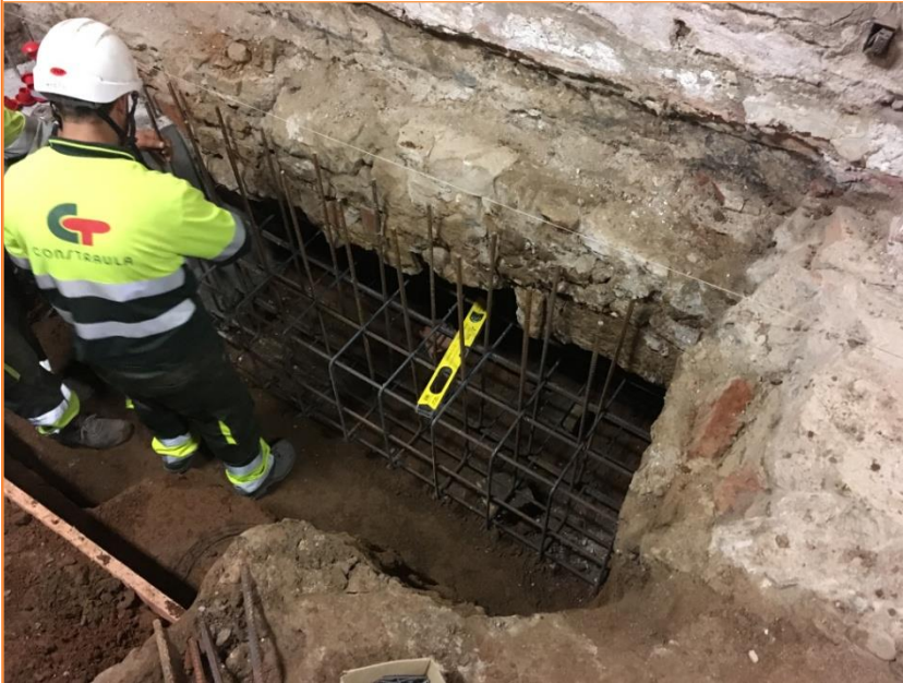
Foto 15. Vista de la refonamentació del mur UE 31.
